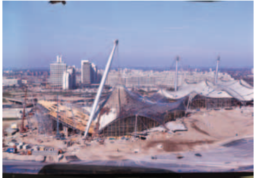
Die Großbaustelle auf dem Oberwiesenfeld, hier im Vordergrund die Olympia-Schwimmhalle.
